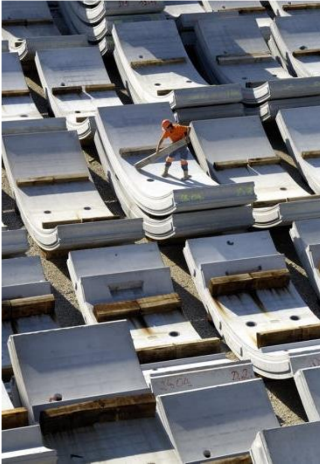
Aire de préfabrication des voussoirs A41 Anancy © Véronique Paul
